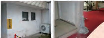
建物の外壁に生じた亀裂
